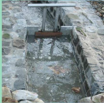
Zudem erlaubt ein kleiner Pegel die Messung der Wassertiefe, die bei der Pfarrgräfte maßgeblich vom Grundwasserstand bestimmt wird.
